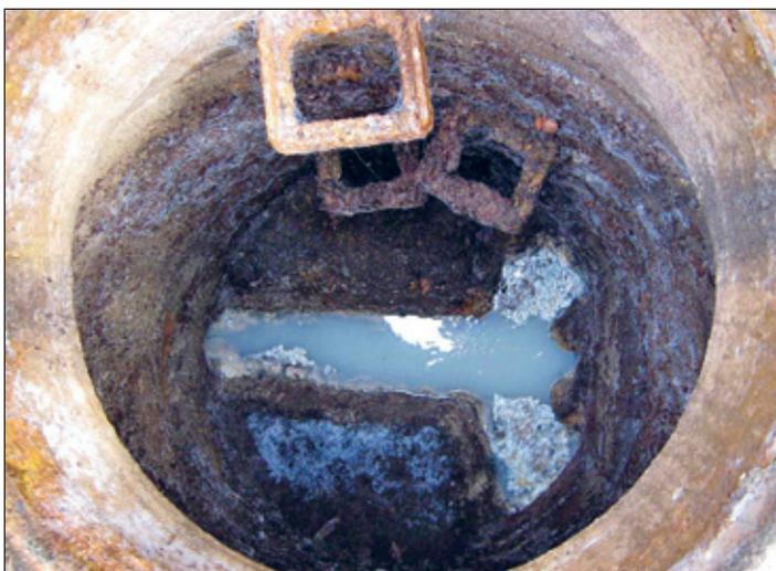
Korrosion im Schacht durch Fette und Öle (Beispiel)
