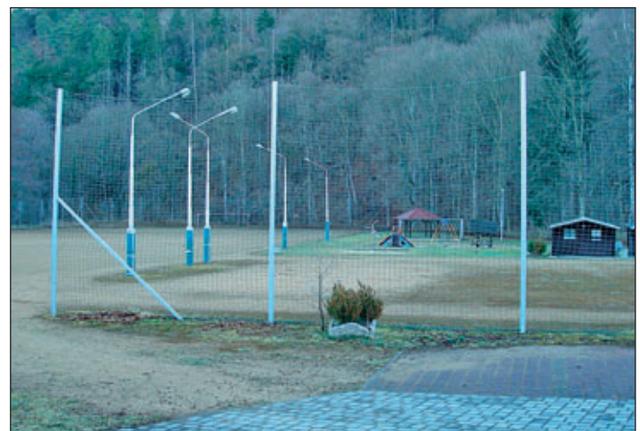
Im Foto: Derzeitiger Zustand des Hartplatzbereiches
