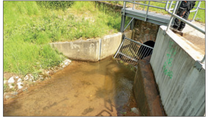
Bestehender Rechen am HRB Glashütte II
